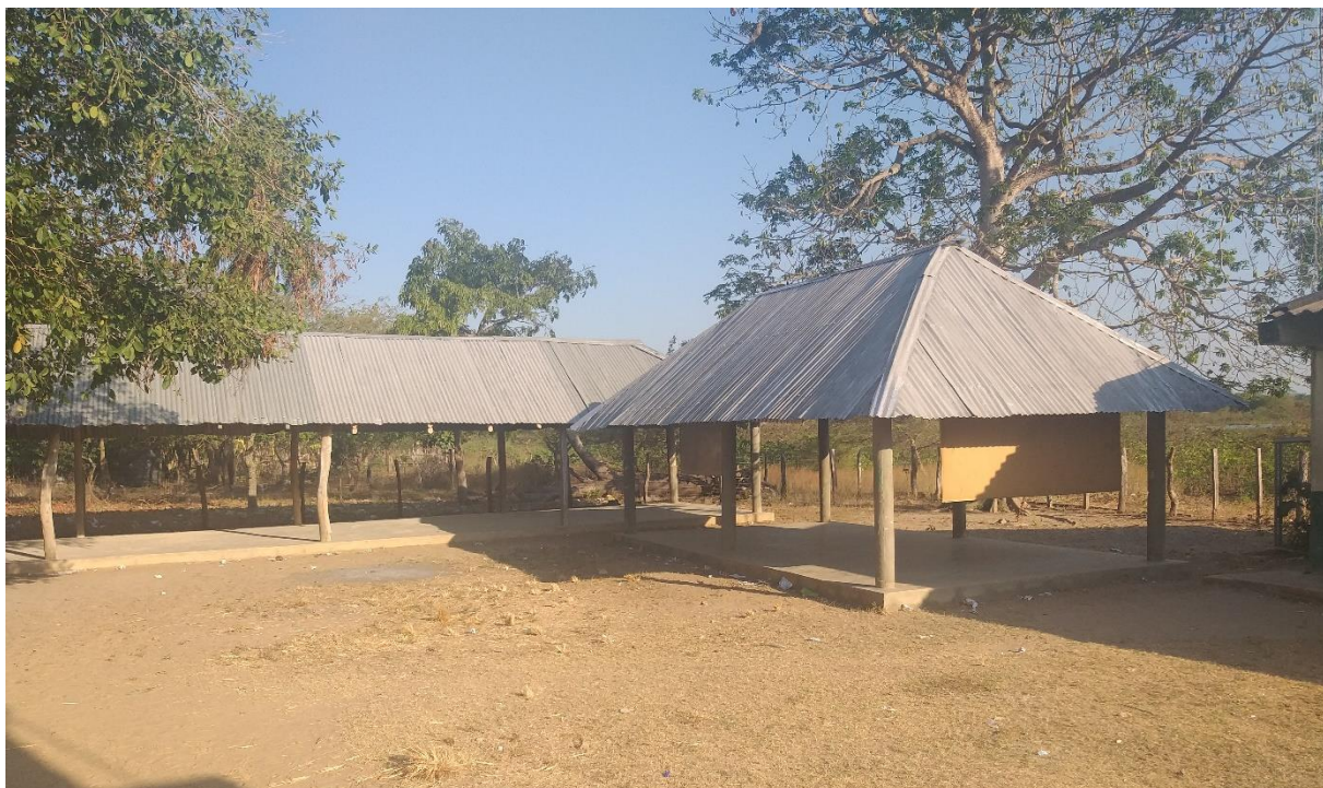
Aula de clase en la I.E. del corregimiento de Jaraba la cual está siendo reubicada por el Fondo de Adaptación por el riesgo de inundación. Fuente: Elaboración propia. 2020.
